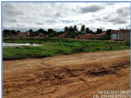
Figura 3-27- Construções em área de risco de inundação, em Lagoa do 33
