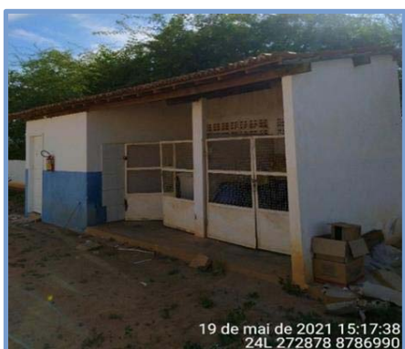
Figura 3-11- Área de armazenamento dos resíduos contaminados
