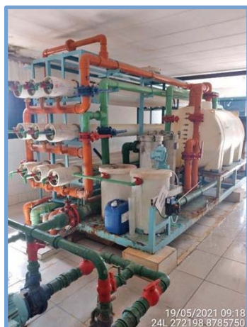
Figura 3-4- Dessalinizadores utilizados na ETA Fonte: COBRAPE (2021)
