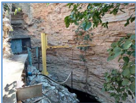
Figura 3-2- Captação de água no Poço Verde Fonte: COBRAPE (2021)
